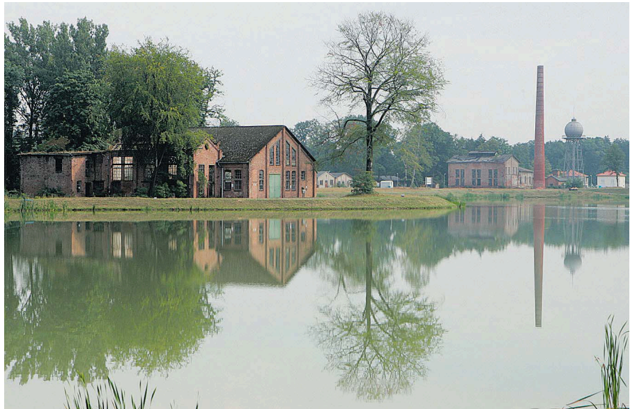
Idyllisch gelegen: Das alte Backsteinhaus am See harret noch einer neuen Nutzung. Rechts daneben liegt im Hintergrund das Kesselhaus. Das ehemalige Maschinenhaus wird bald zu Büros und Wohnungen umgebaut. Daneben steht ein alter Fabrikschornstein und der Wasserturm mit dem Kugel-Behälter. Er überragt den Campus Nobel wie ein Wahrzeichen. Fotos: Thomas Seeber
